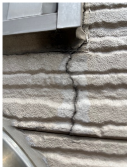
③外壁パネル亀裂
